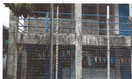
Foto 10 Pintura en muros exteriores e interiores
