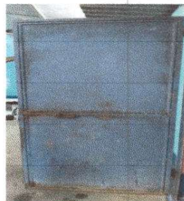
foto 2 Sustrucción de puerta en servicios sanitarios
