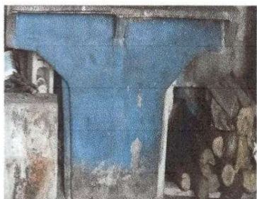
Foto 7 Sustrucción de pila de cemento de dos lavaderos
