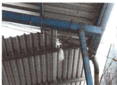
Foto 11 Sustrucción de focos ahorradores
