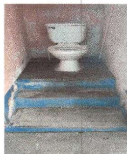
Foto 4 Sustrucción de piso ceramico
