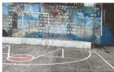
Foto 9 Pintura en muros exteriores e interiores
