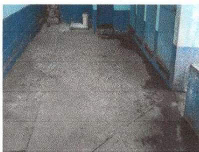
Foto 3 Sustrucción de piso ceramico
