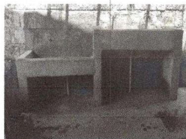
Foto 6 Sustrucción de lavamanos
