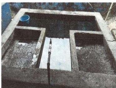
Foto 15 Sustitución de pila de cemento de dos lavaderos
