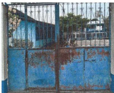
Foto 1 Sustrucción de porton de metal
